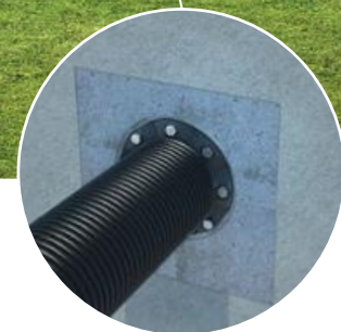
Узел прохода через стену для влажных помещений
